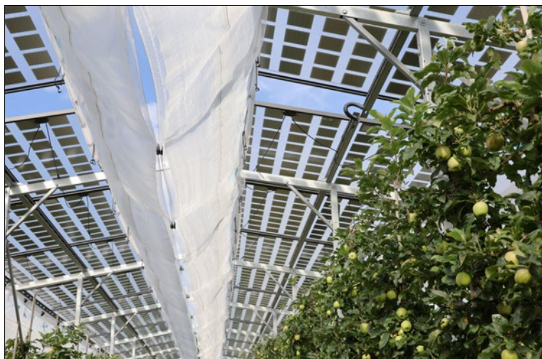
Tussen de zonnepanelen is hagel- en regenwerende folie aangebracht. EFM
